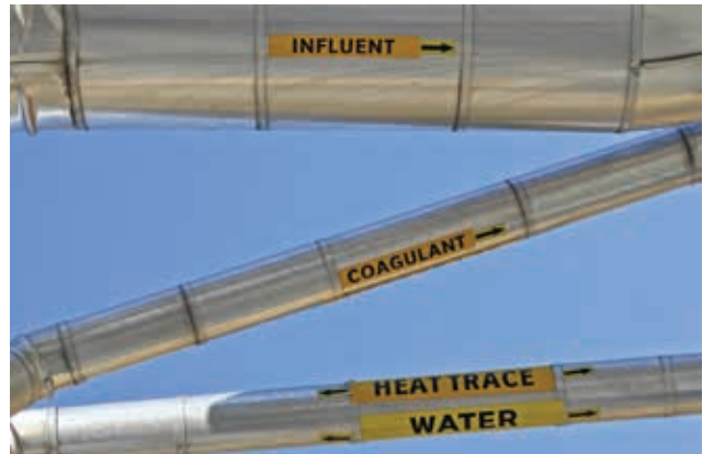
Endüstriyel ortamlarda boru işaretleme
