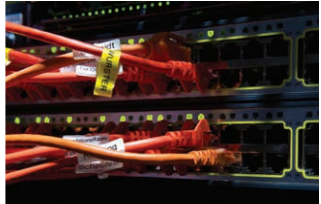
Spezielle Formate und Materialien für die Kabelkennzeichnung: vertikale oder horizontale Fähnchen, selbstlaminierende Umhüllungen und Schrumpfschläuche
